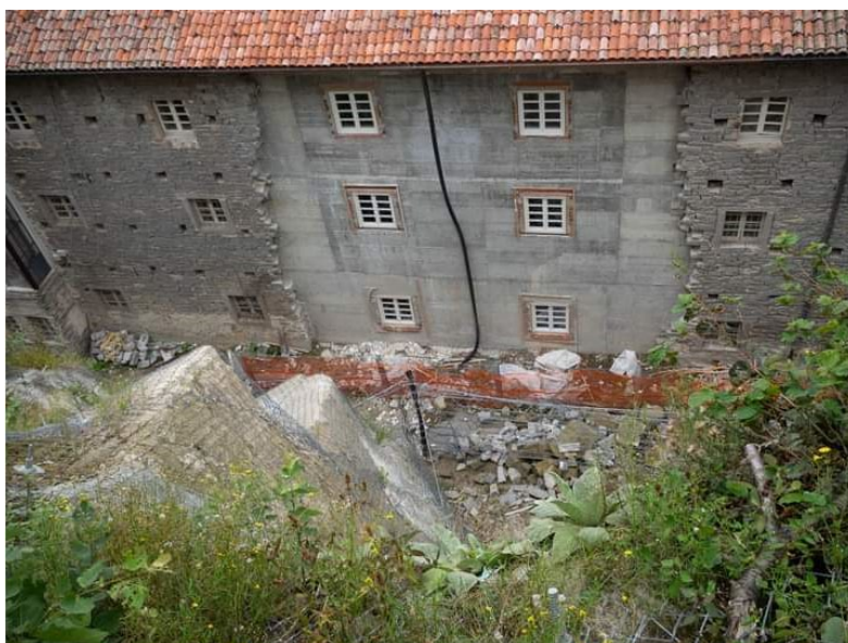
Completati i lavori dell'Ala Pellegrini
